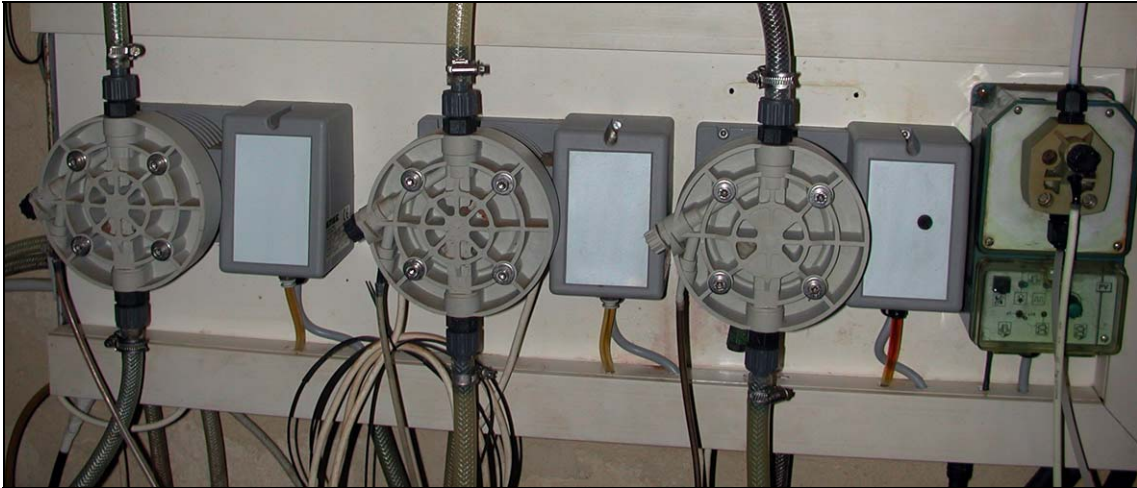
Fig.1. Particolare dell’impianto di fertirrigazione utilizzato per la preparazione della soluzione nutritiva, composto da tre pompe dosatrici a membrana per le soluzioni stocks e una per il dosaggio dell’acido (pompa piccola sulla destra).
